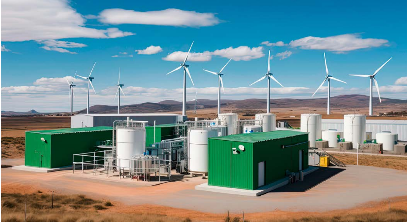
Elektrolyseanlagen werden durch Multiplikation der Module skaliert.
